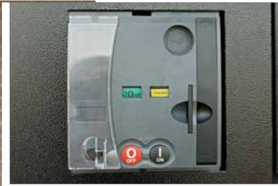
▲ Interruptor motorizado para la sincronización de los generadores eléctricos
