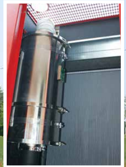
▲ Filtro catalítico para reducir las emisiones de escape
