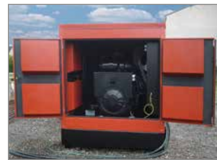
▲ Entradas de aire para evitar filtraciones de agua
